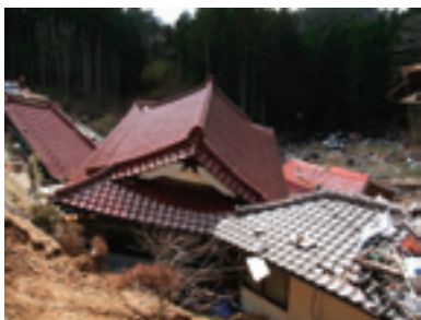
津波で倒壊した「唐桑御殿」
